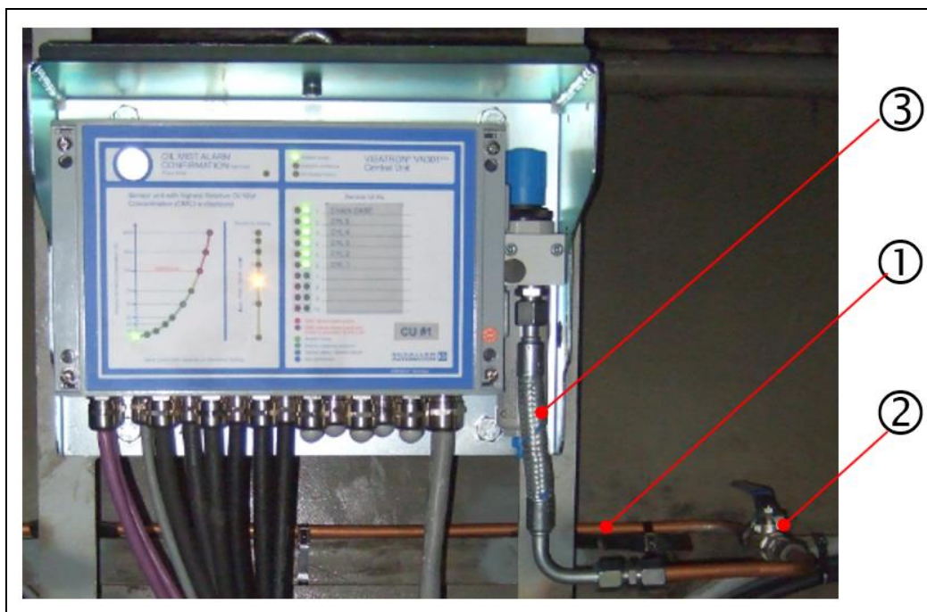
Fig.: 14 : Esempio di un'alimentazione ottimale dell'aria compressa all'unità centrale VN301 plus
