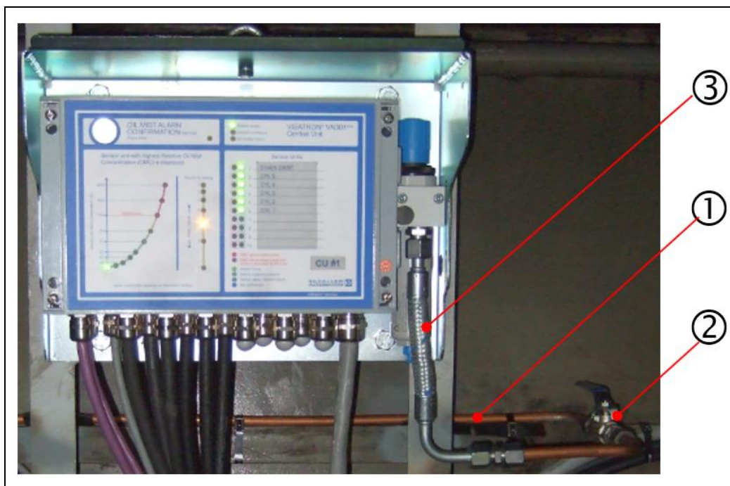
Fig.: 14 : Ejemplo de una alimentación óptima de aire comprimido en la unidad central VN301 plus
